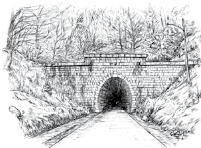
Las Raíces Tunnel
